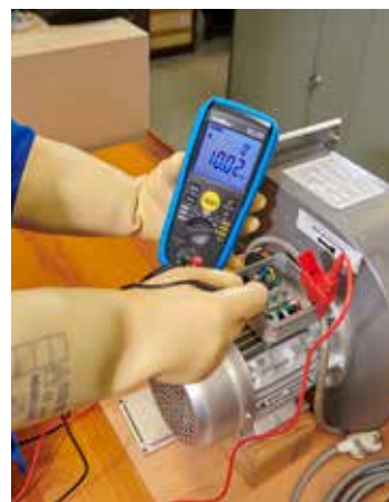
Mantenimiento preventivo en un motor
