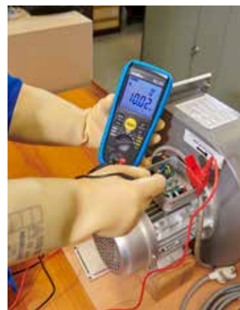
Vorbeugende Wartung an einem Motor
